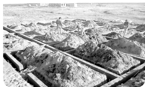
Начало строительства в Куе
