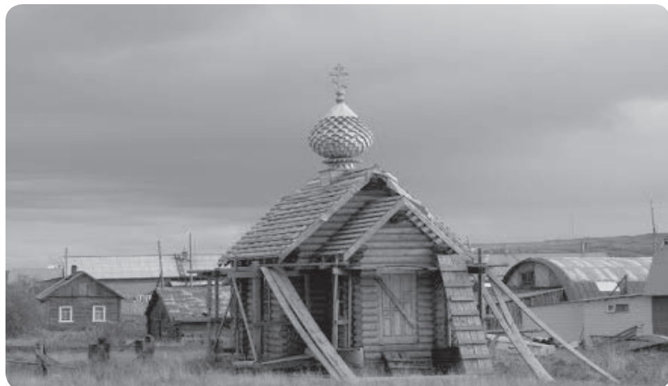
В Индиге идёт строительство часовни
