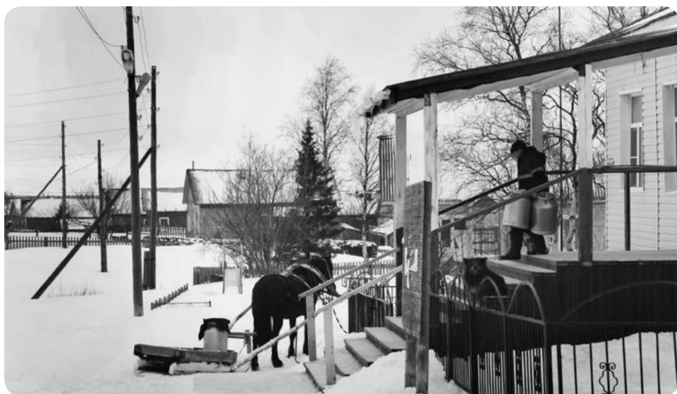
В Оме летом начнётся реконструкция ЛЭП
