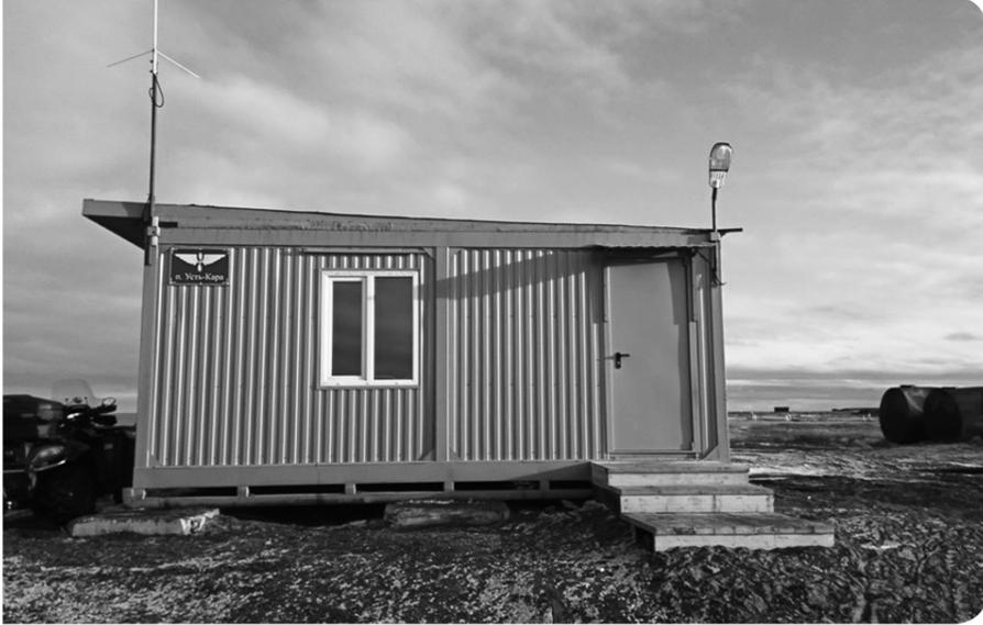
Мобильные здания контейнерного типа, состоящие из цельносварных блок-контейнеров, в северном исполнении включают в себя всё необходимое внутреннее инженерное обеспечение (отопление, электрическое освещение), расчётная температура воздуха в помещении 20 С°.
