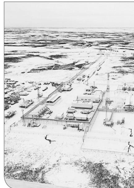
рьё с Восточного Сарутаю пройдёт первый этап подготовки и после отправится на центральный пункт сбора нефти «Южное Хыльчучу». Производительность мультифазной насосной станции — 580,6 тысячи тонн нефти в год.
