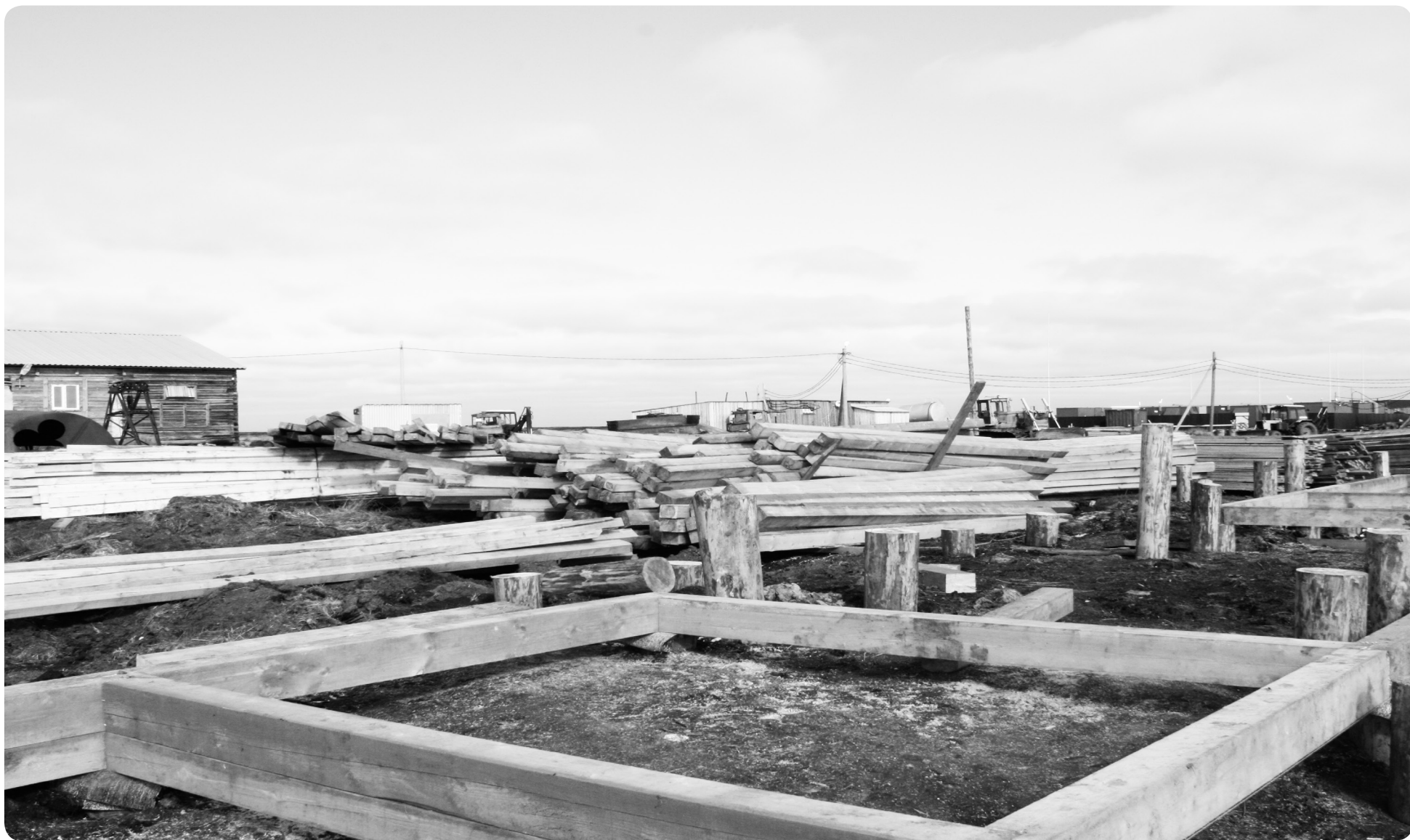
Строительство школы-сада в Бугрино
