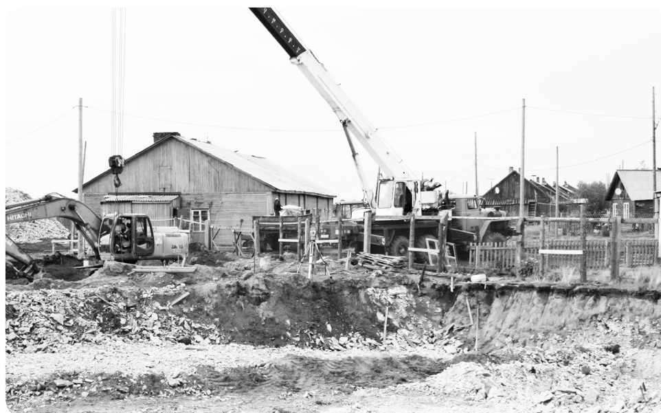
Строительство школы в Инди́ге
